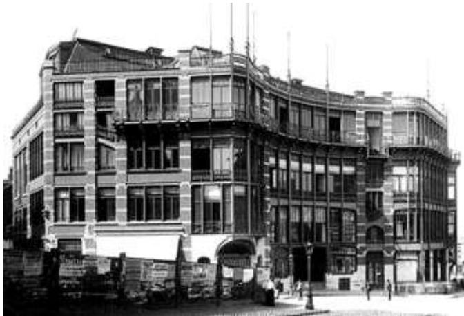
Foto 2: A antiga Maison du Peuple ("Casa do Povo") em Bruxelas (Bélgica), desenhada por Victor Horta (1896-1898), que foi demolida em 1965 pelas autoridades da cidade apesar do protesto de muitos arquitectos e do comité internacional da Carta de Veneza para fins de desenvolvimento urbano (foi construído um arranha-céus no seu local).
